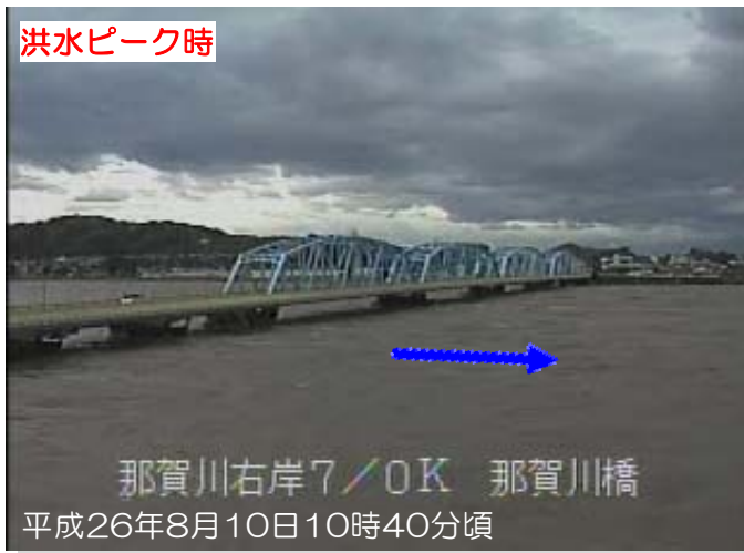
▲那賀川橋（那賀川河口から7km付近）
